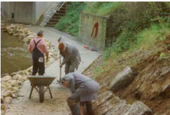
Der Weg unter den Bachbrücken ist bald fertig
