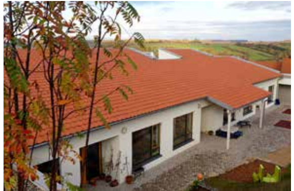
Foto: Kaum fertiggestellt, ist die neue Kinderkrippe in Schonungen auch schon wieder nahezu vollständig belegt. 36 Kleinkinder besuchen aktuell die neue Einrichtung. (Foto St. Rottmann)
