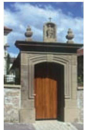
...und nach der Renovierung
